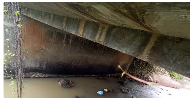
KONDISI BANGUNAN BAWAH
