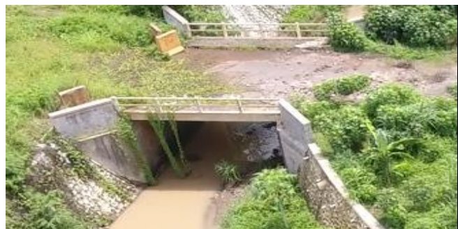
TAMPAK ATAS BAGIAN KANAN
