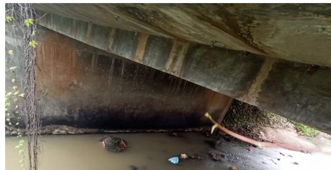
KONDISI BANGUNAN BAWAH
