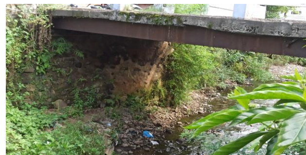
KONDISI BANGUNAN BAWAH
