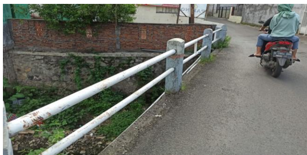
KONDISI SANDARAN SISI KIRI
