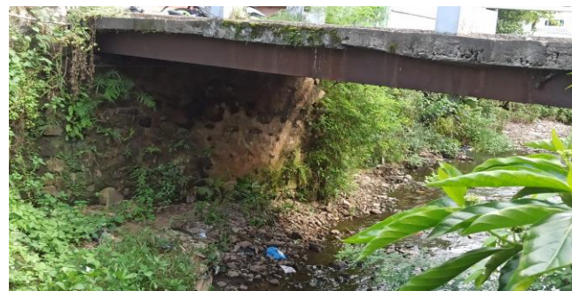
KONDISI BANGUNAN BAWAH
