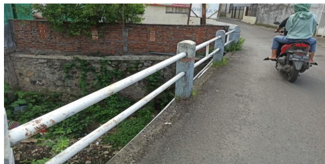
KONDISI SANDARAN SISI KIRI
