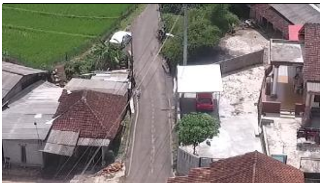
TAMPAK ATAS BAGIAN DEPAN
