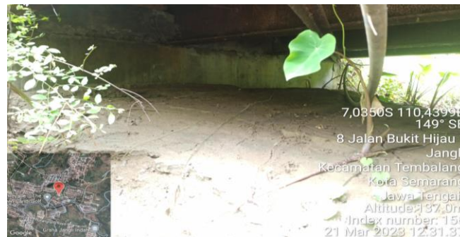
KONDISI BANGUNAN BAWAH
