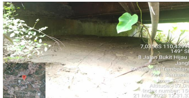
KONDISI BANGUNAN BAWAH
