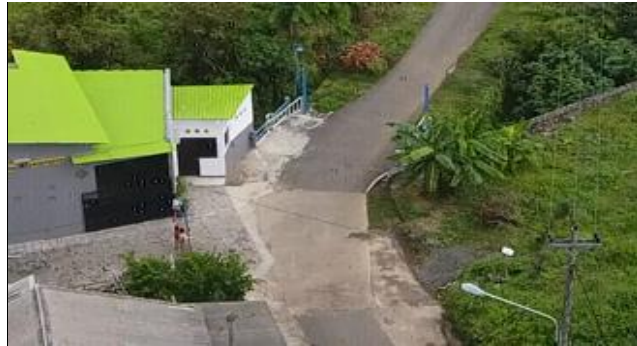
TAMPAK ATAS BAGIAN DEPAN
