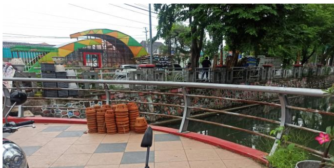
KONDISI SANDARAN SISI KIRI
