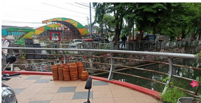
KONDISI SANDARAN SISI KIRI
