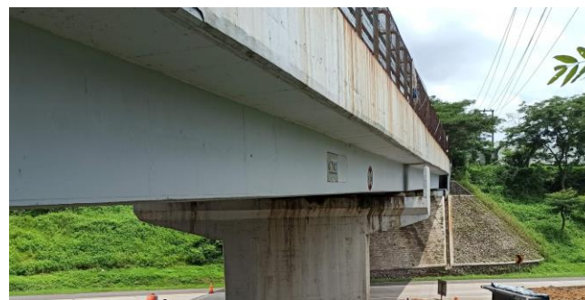
KONDISI BANGUNAN BAWAH
