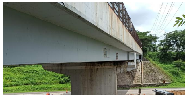
KONDISI BANGUNAN BAWAH
