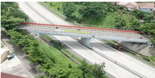
TAMPAK ATAS BAGIAN KANAN
