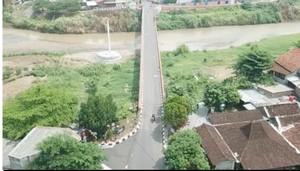
TAMPAK ATAS BAGIAN DEPAN
