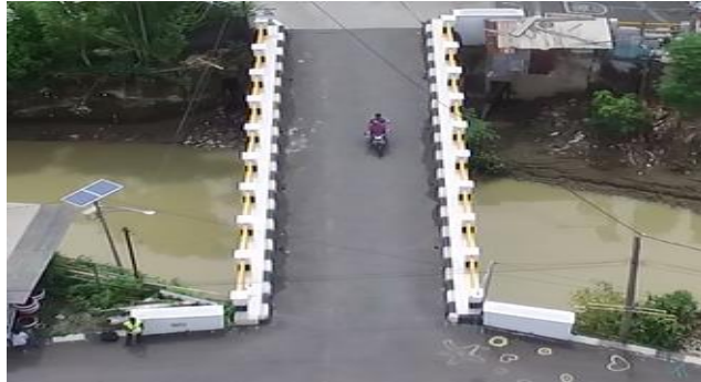
TAMPAK ATAS BAGIAN DEPAN
