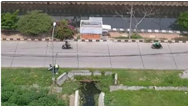
TAMPAK ATAS BAGIAN KANAN
