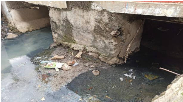
KONDISI BANGUNAN BAWAH
