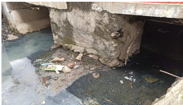
KONDISI BANGUNAN BAWAH
