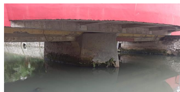
KONDISI BANGUNAN BAWAH
