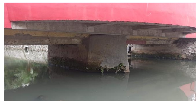
KONDISI BANGUNAN BAWAH
