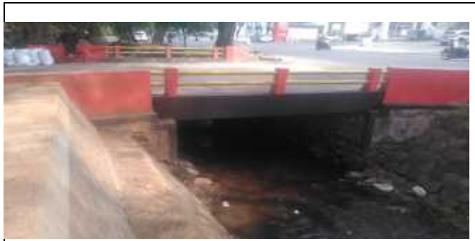
Tampak Smping Kiri
