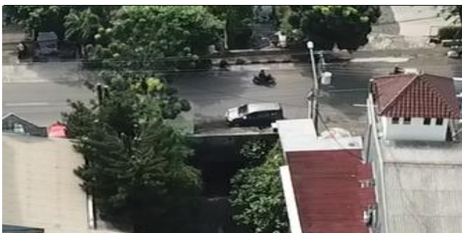
TAMPAK ATAS BAGIAN KANAN
