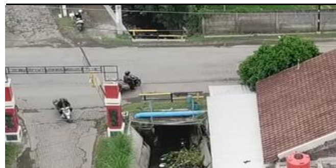
TAMPAK ATAS BAGIAN KANAN
