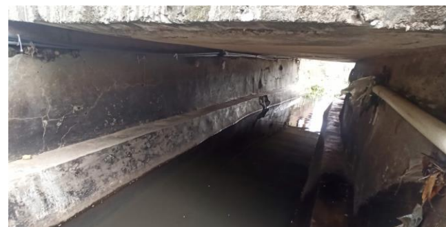
KONDISI BANGUNAN BAWAH
