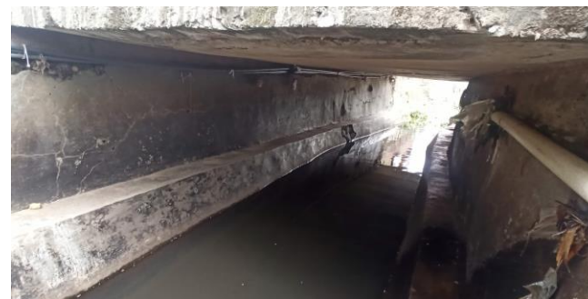
KONDISI BANGUNAN BAWAH
