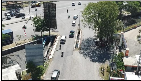
TAMPAK ATAS BAGIAN DEPAN
