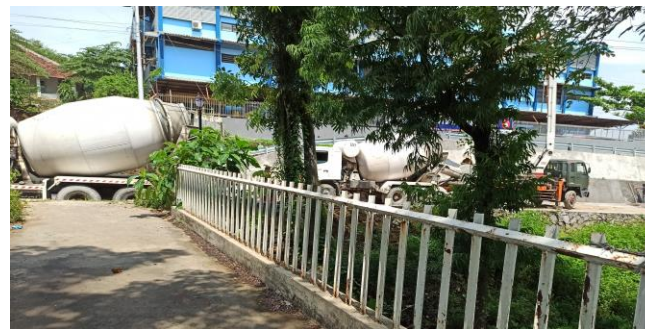
KONDISI SANDARAN SISI KANAN
