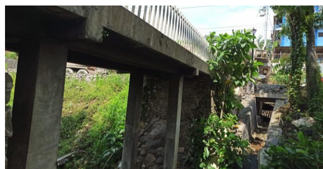
KONDISI BANGUNAN BAWAH
