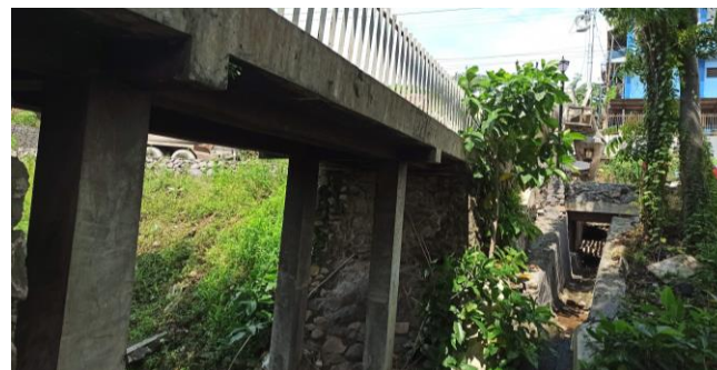
KONDISI BANGUNAN BAWAH
