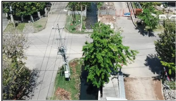
TAMPAK ATAS BAGIAN KANAN
