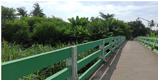
KONDISI SANDARAN SISI KIRI
