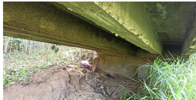
KONDISI BANGUNAN BAWAH
