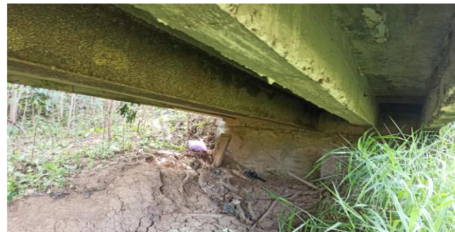
KONDISI BANGUNAN BAWAH
