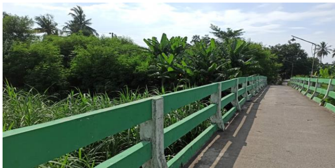
KONDISI SANDARAN SISI KIRI
