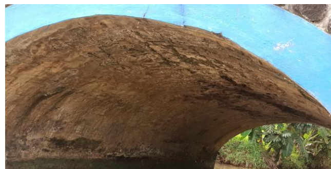
KONDISI BANGUNAN BAWAH
