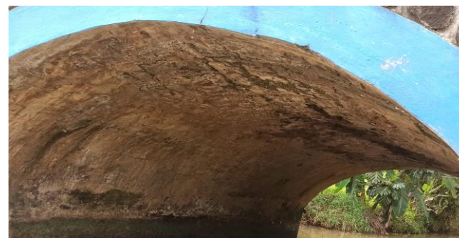
KONDISI BANGUNAN BAWAH
