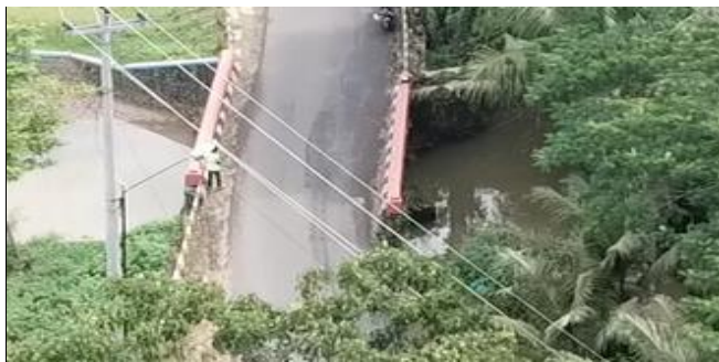
TAMPAK ATAS BAGIAN DEPAN
