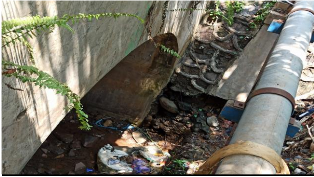
KONDISI BANGUNAN BAWAH
