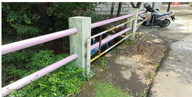
KONDISI SANDARAN SISI KIRI
