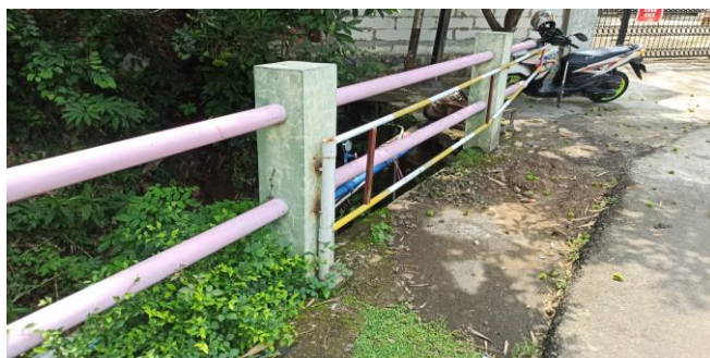
KONDISI SANDARAN SISI KIRI
