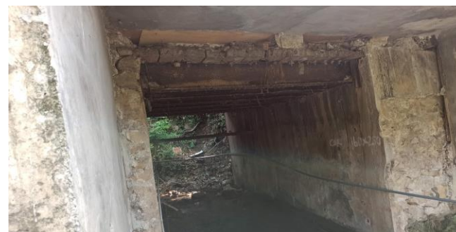
KONDISI BANGUNAN BAWAH
