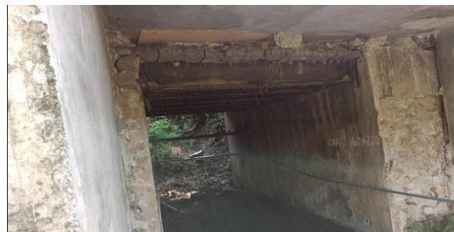
KONDISI BANGUNAN BAWAH
