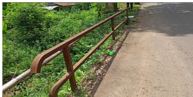
KONDISI SANDARAN SISI KIRI
