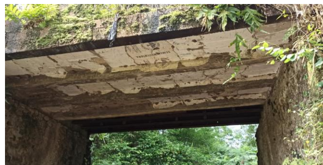
KONDISI BANGUNAN BAWAH
