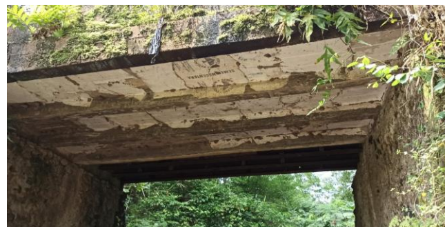
KONDISI BANGUNAN BAWAH
