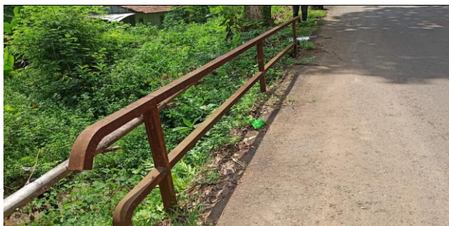
KONDISI SANDARAN SISI KIRI
