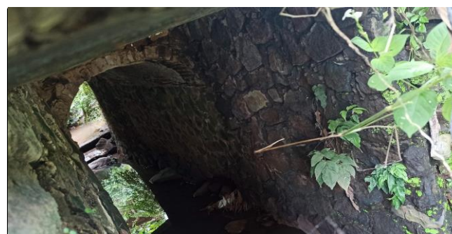
KONDISI BANGUNAN BAWAH
