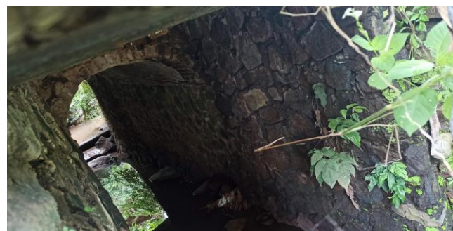
KONDISI BANGUNAN BAWAH
