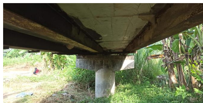
KONDISI BANGUNAN BAWAH
