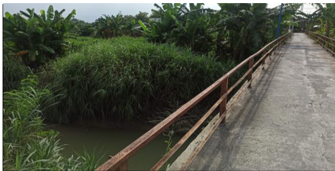
KONDISI SANDARAN SISI KIRI
