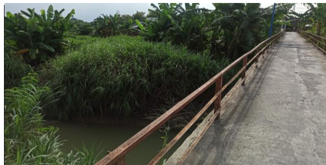
KONDISI SANDARAN SISI KIRI
