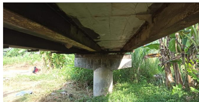
KONDISI BANGUNAN BAWAH
