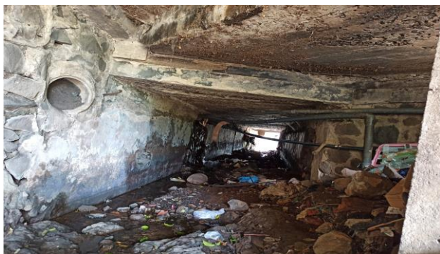
KONDISI BANGUNAN BAWAH
