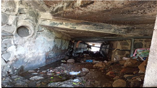
KONDISI BANGUNAN BAWAH
