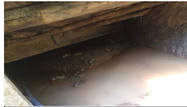
KONDISI BANGUNAN BAWAH
