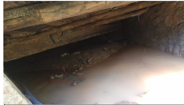
KONDISI BANGUNAN BAWAH
