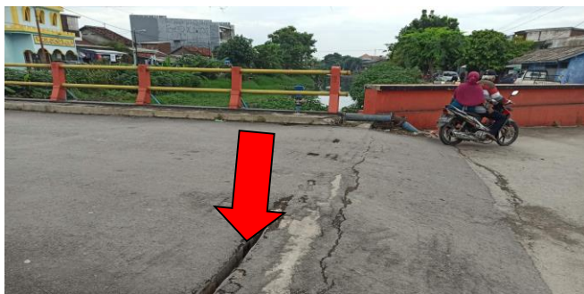
SISTEM SAMBUNGAN LANTAI LONGGAR
