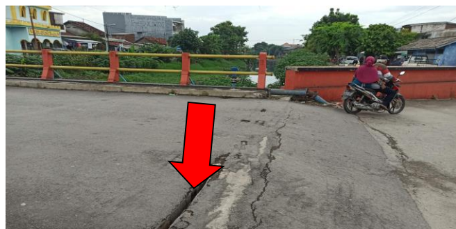
KONDISI SANDARAN SISI KIRI
