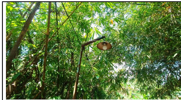
KONDISI LAMPU PENERANGAN JEMBATAN
