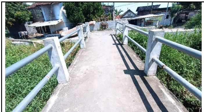
KONDISI SANDARAN JEMBATAN
