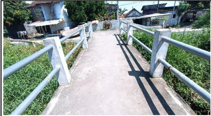
KONDISI SANDARAN JEMBATAN
