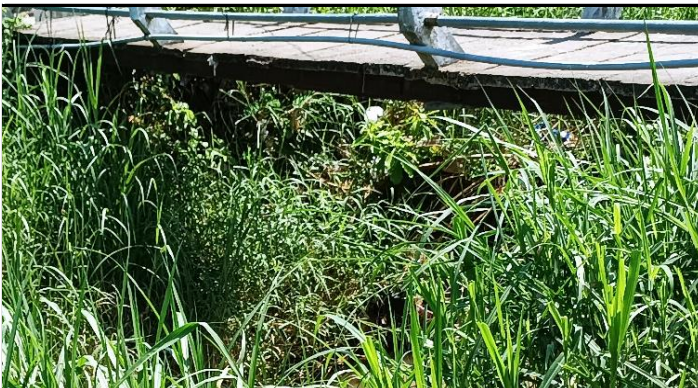
KONDISI PELAT JEMBATAN
