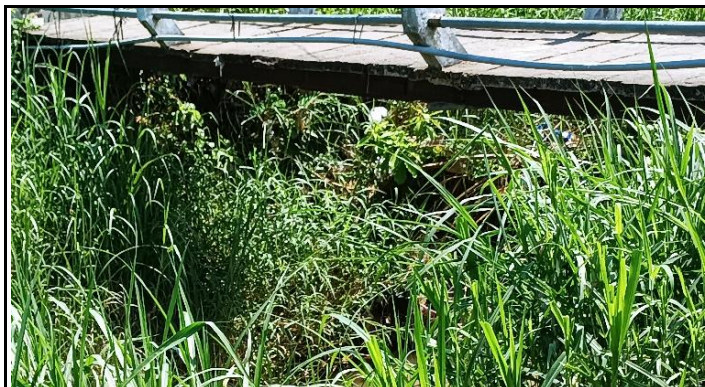
KONDISI PELAT JEMBATAN
