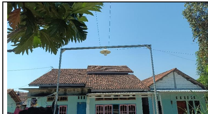
LAMPU PENERANGAN DAN PORTAL JEMBATAN
