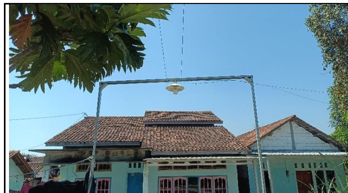
LAMPU PENERANGAN DAN PORTAL JEMBATAN
