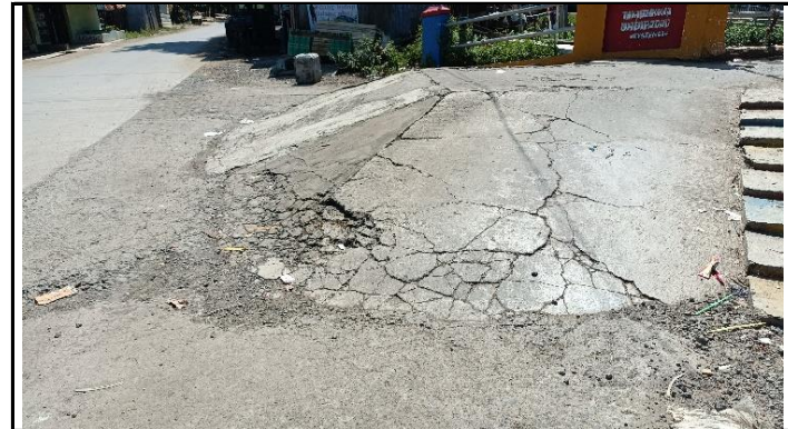
KONDISI JALAN PENDEKAT
