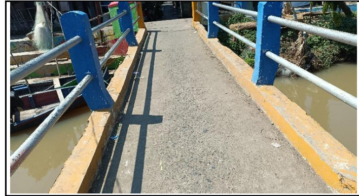
KONDISI LAPISAN PERMUKAAN LANTAI DAN SANDARAN
