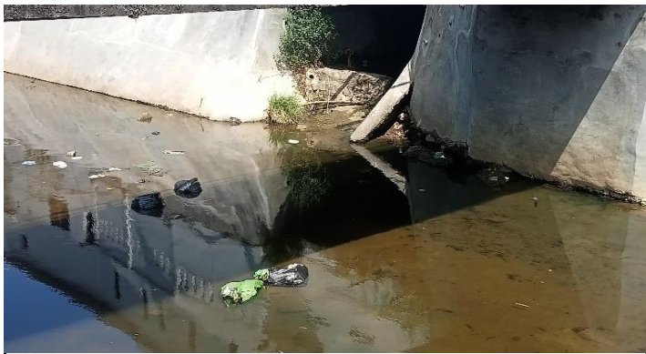
KONDISI BANGUNAN BAWAH
