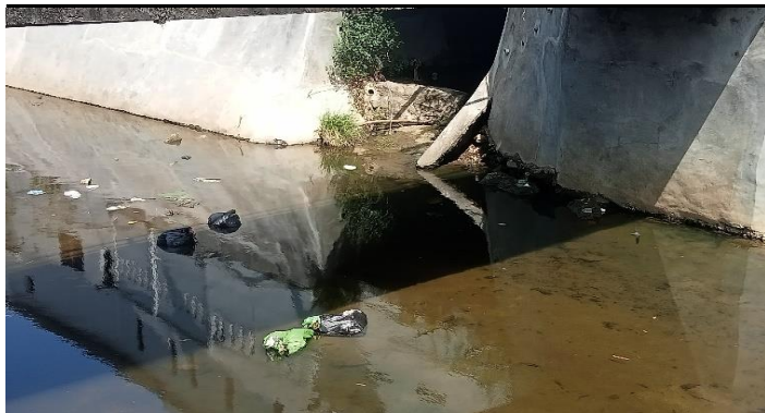
KONDISI BANGUNAN BAWAH
