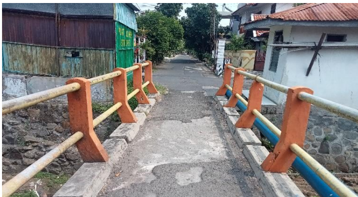
LAPISAN PERMUKAAN LANTAI MENGLUPAS
