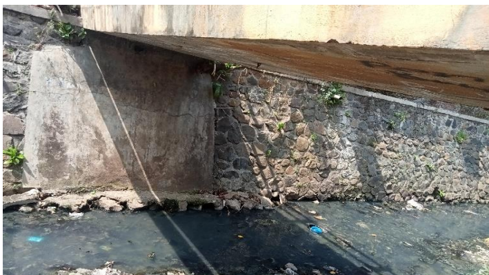
KONDISI BANGUNAN BAWAH
