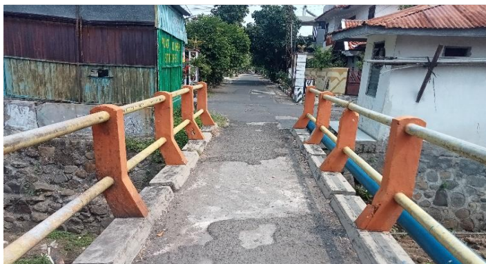
LAPISAN PERMUKAAN LANTAI MENGLUPAS
