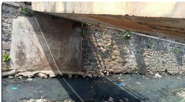
KONDISI BANGUNAN BAWAH
