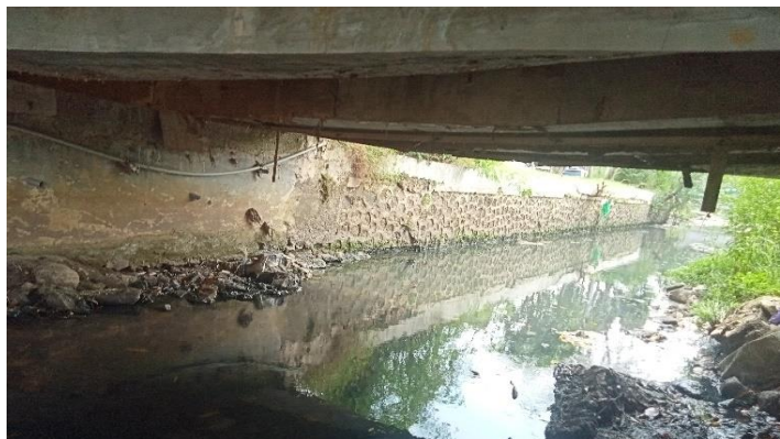
KONDISI BANGUNAN BAWAH
