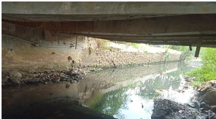
KONDISI BANGUNAN BAWAH
