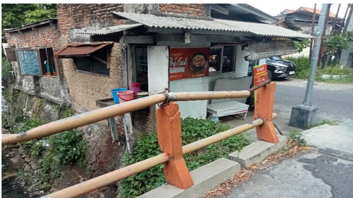
KONDISI SANDARAN HORIZONTAL BERUBAH BENTUK
