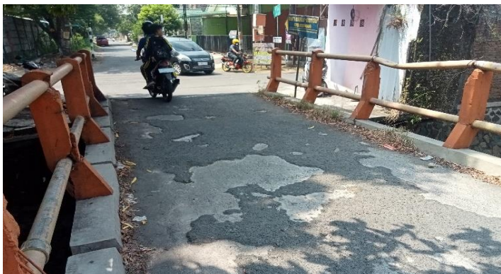
LAPISAN PERMUKAAN LANTAI MENGLUPAS
