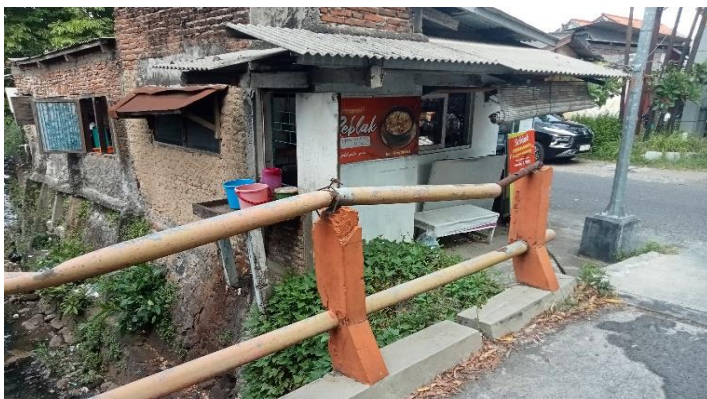
KONDISI SANDARAN HORIZONTAL BERUBAH BENTUK
