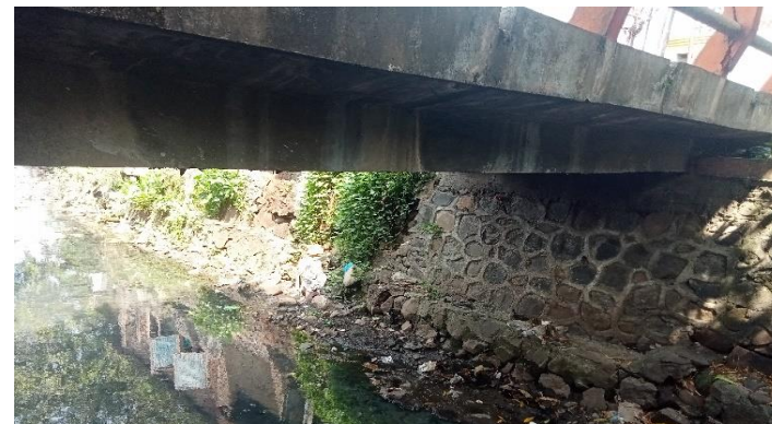
KONDISI BANGUNAN BAWAH
