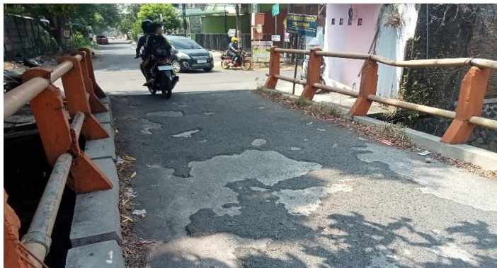
LAPISAN PERMUKAAN LANTAI MENGLUPAS
