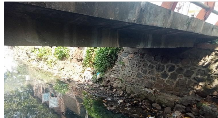
KONDISI BANGUNAN BAWAH
