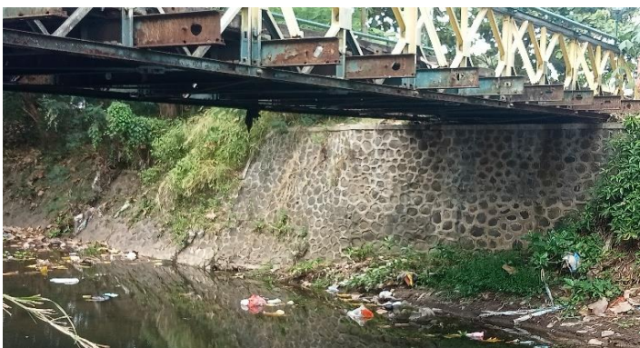
KONDISI BANGUNAN BAWAH
