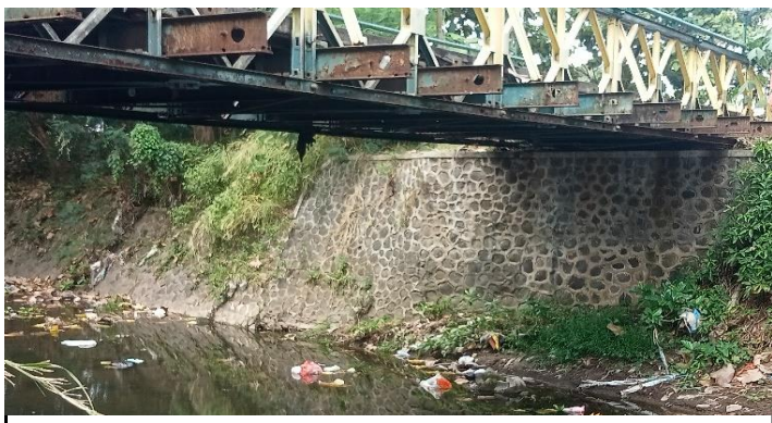
KONDISI BANGUNAN BAWAH
