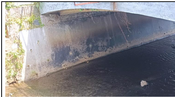
KONDISI BANGUNAN BAWAH
