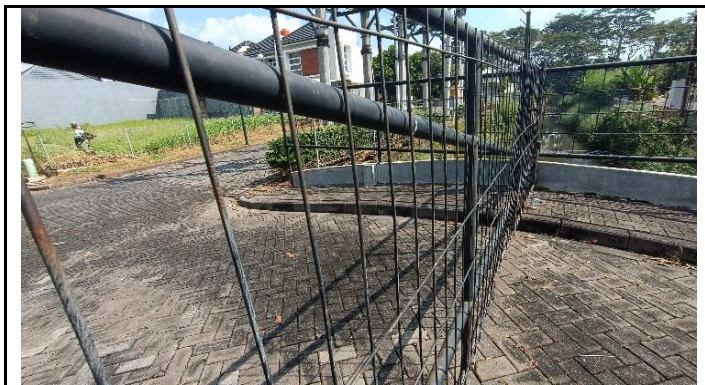
KONDISI BANGUNAN ATAS DI GERBANG
