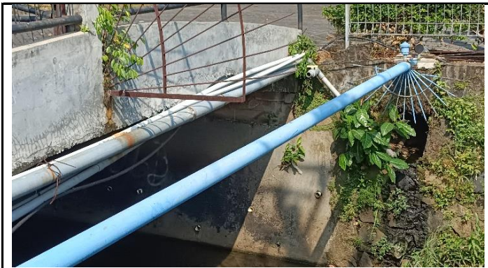
KONDISI PIPA UTILITAS AIR MINUM
