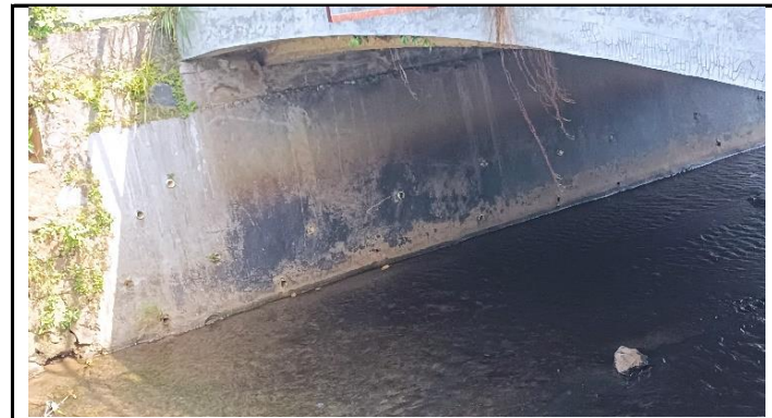
KONDISI BANGUNAN BAWAH
