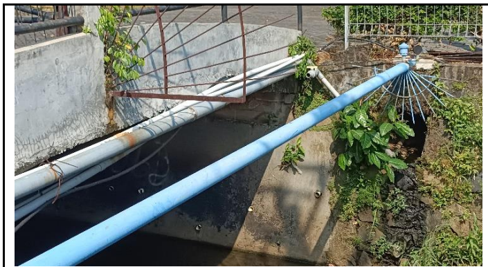
KONDISI PIPA UTILITAS AIR MINUM
