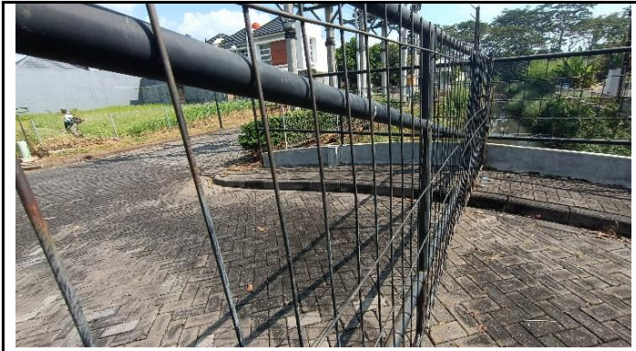
KONDISI BANGUNAN ATAS DI GERBANG
