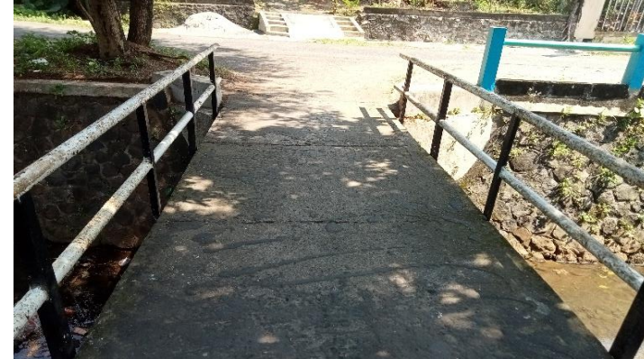
KONDISI LAPISAN PERMUKAAN LANTAI
