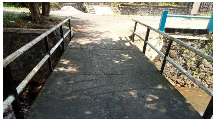
KONDISI LAPISAN PERMUKAAN LANTAI
