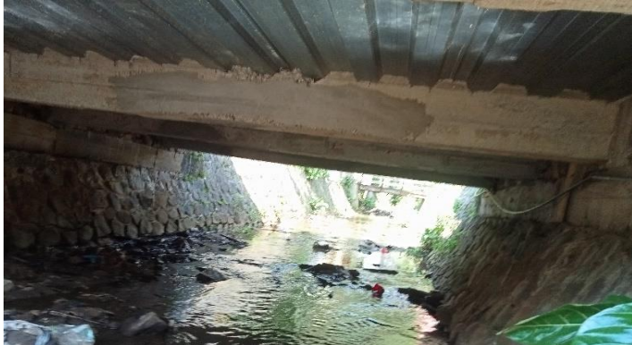
KONDISI BANGUNAN BAWAH
