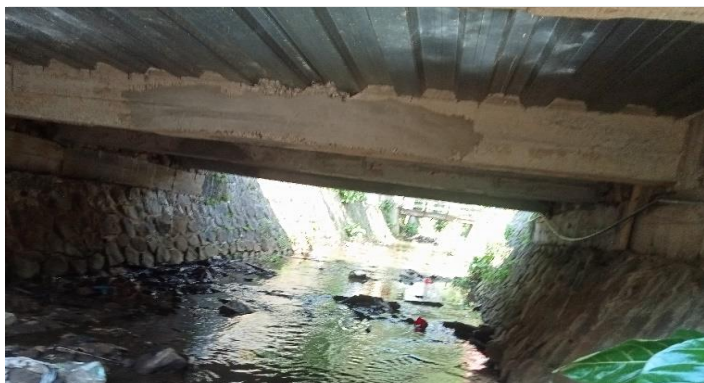
KONDISI BANGUNAN BAWAH
