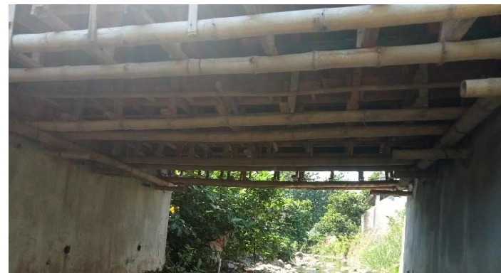
KONDISI BANGUNAN BAWAH
