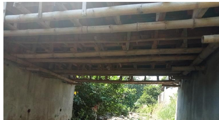
KONDISI BANGUNAN BAWAH
