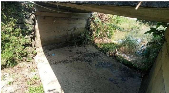
KONDISI BANGUNAN BAWAH
