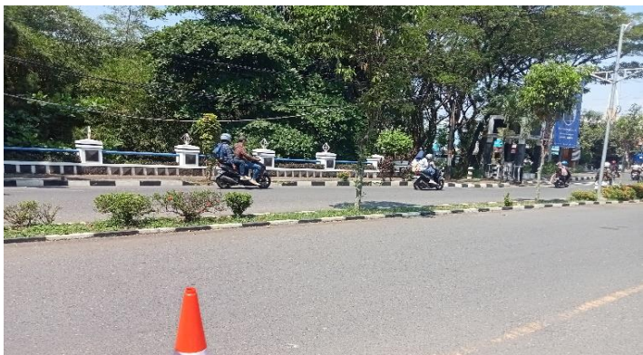
KONDISI LAPISAN PERMUKAAN LANTAI
