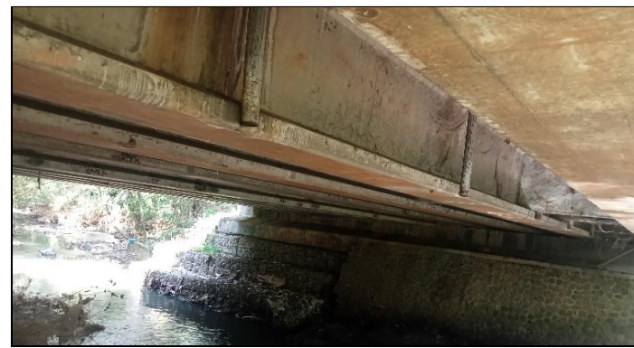
KONDISI BANGUNAN BAWAH
