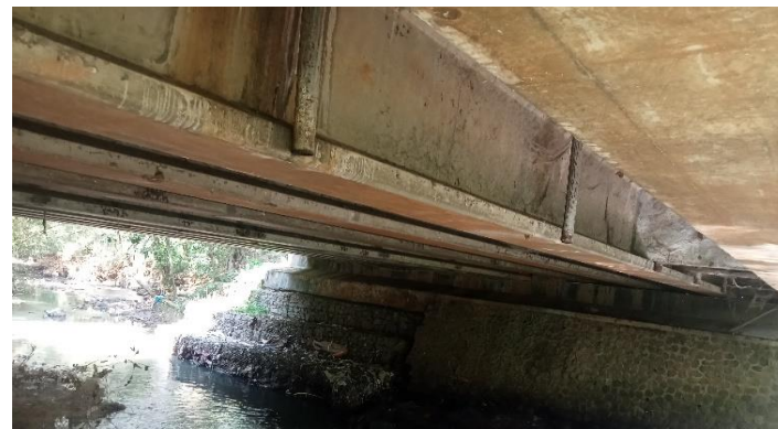
KONDISI BANGUNAN BAWAH
