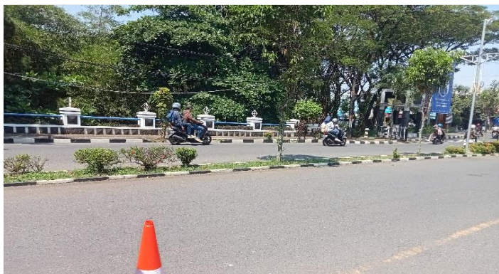
KONDISI LAPISAN PERMUKAAN LANTAI
