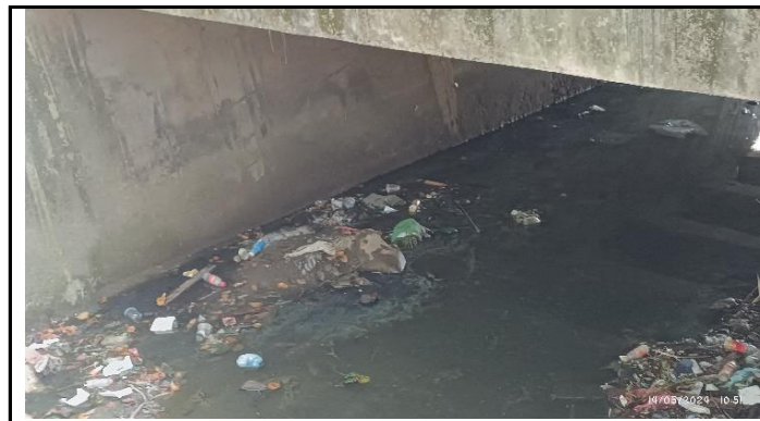
KONDISI BANGUNAN BAWAH
