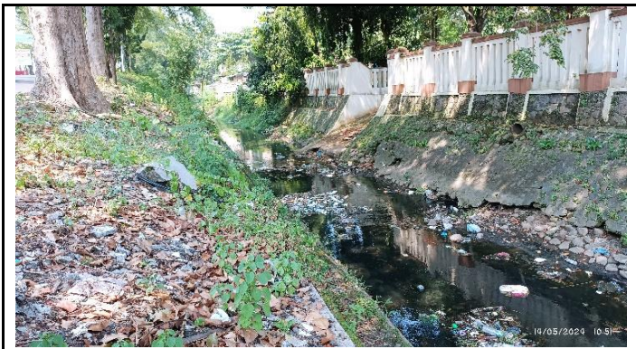
KONDISI ALIRAN SUNGAI PENUH LIMBAH DAN SAMPAH
