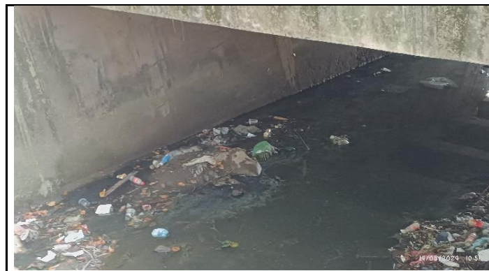
KONDISI BANGUNAN BAWAH
