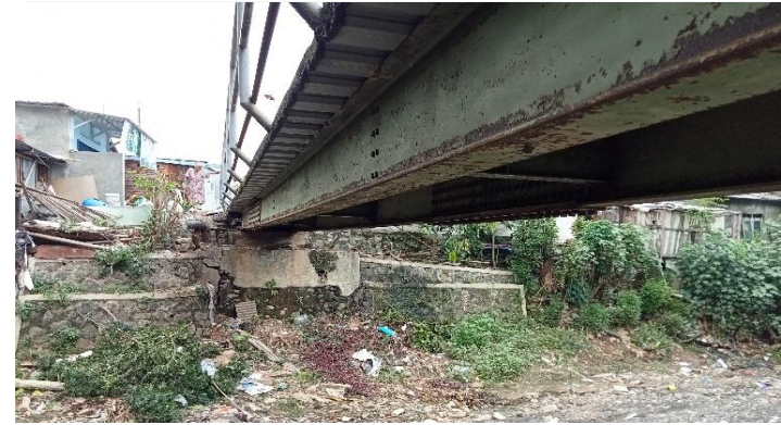
KONDISI BANGUNAN BAWAH
