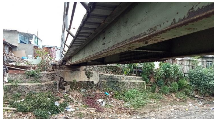
KONDISI BANGUNAN BAWAH
