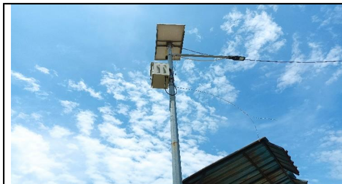
KONDISI PENERANGAN JEMBATAN
