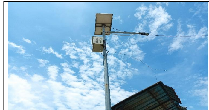
KONDISI PENERANGAN JEMBATAN
