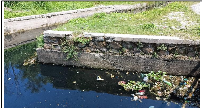
KERONTOKAN BETON PADA TIANG SANDARAN
