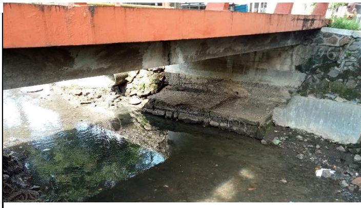
KONDISI BANGUNAN BAWAH
