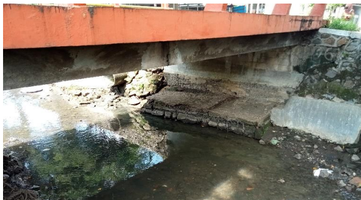
KONDISI BANGUNAN BAWAH
