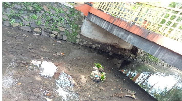
KONDISI BANGUNAN BAWAH
