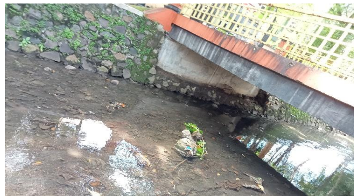
KONDISI BANGUNAN BAWAH
